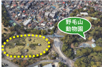
旧野毛山配水池
