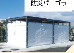
<防災設備の例>
