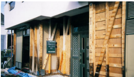
木造家屋耐震補強工事の例
