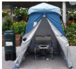
マンホールトイレ
