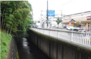
緊急輸送路に隣接した護岸(特殊提)
