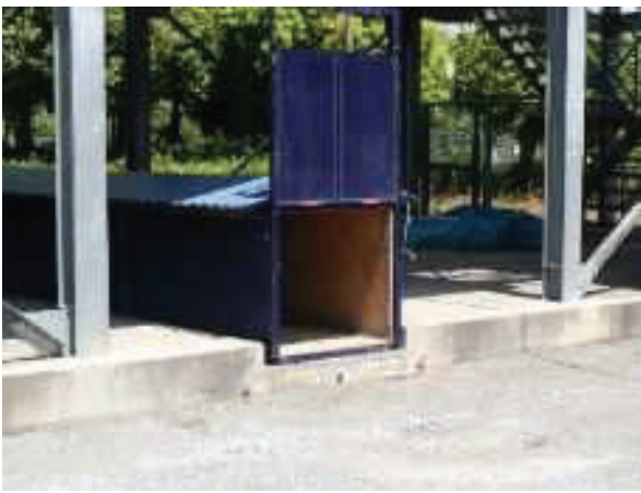
C塔 煙道出口
