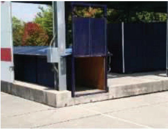
C塔 煙道入口
