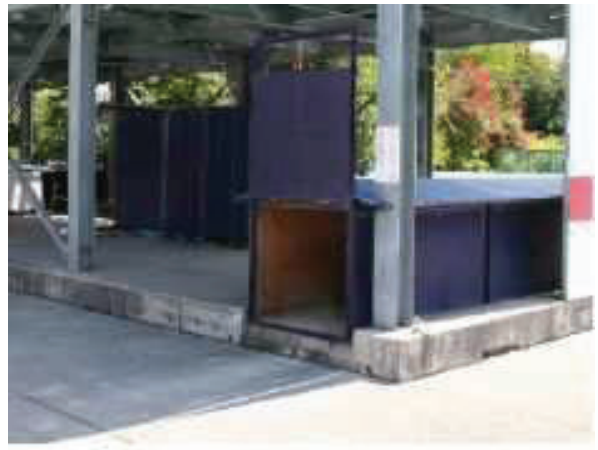
B塔 煙道入口
