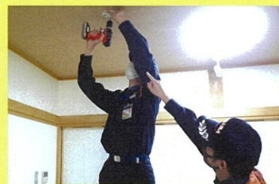
▲消防署員が取付け作業をする様子
