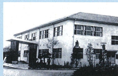
★1949 (昭和24) 6月 横浜市消防局庁舎完成
