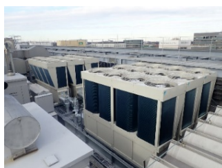
電気式空冷モジュールチラー
