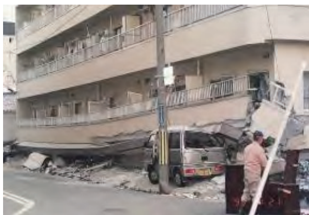
1階のピロティ階が層崩壊したマンション 出典：神戸災害と戦災資料館
