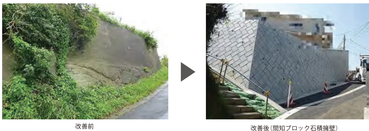
図3-10 崖地防災対策工事助成金制度による改善例
