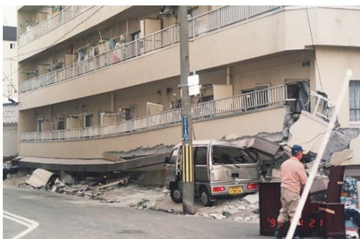
1階のピロティ階が層崩壊したマンション
