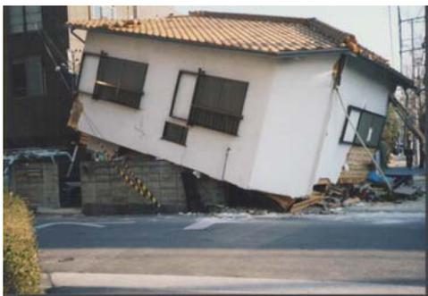
1階部分が層崩壊した木造2階建ての建築物
