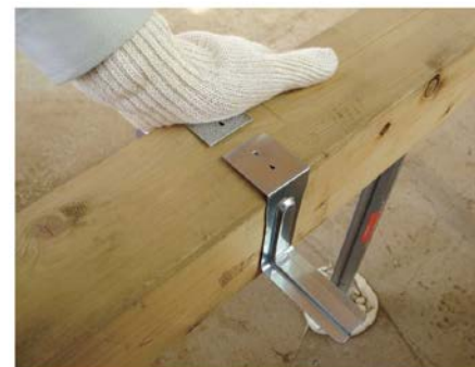
断熱材受け専用金物
