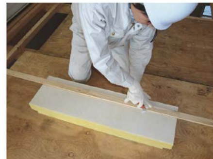
断熱材の切断と施工
