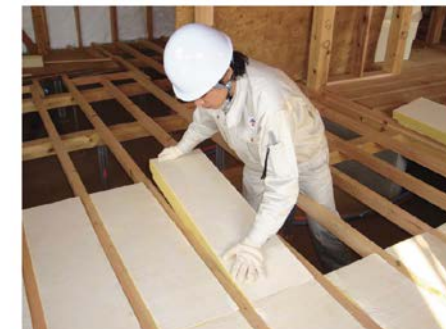
断熱材の切断と施工
