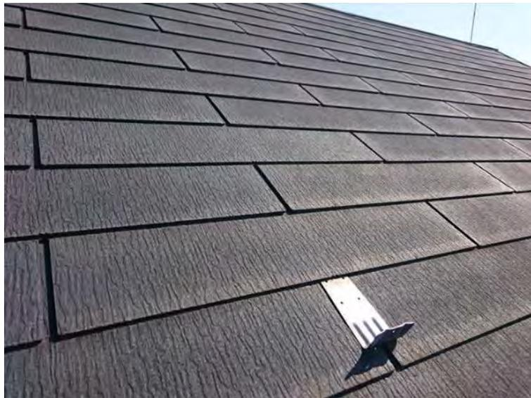
スレートとは薄い板状の屋根材です。昔は石綿とセメントを素材とした石綿スレートでした。しかし現在は健康問題のため、石綿を使用しない無石綿スレートが主流となっています。瓦などと比べて軽いので、多くの住宅の屋根に使用されています。
