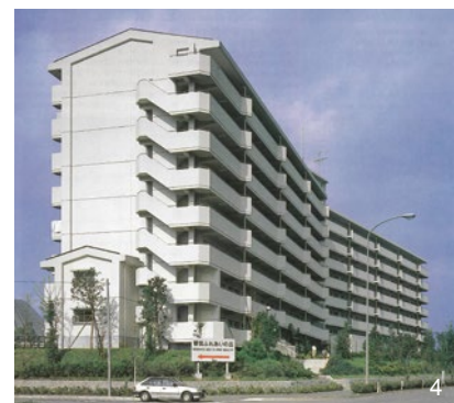
3:1981 金沢第三住宅（横浜市の公営住宅）／4:1984 つづきが丘住宅（横浜市の公営住宅）21世紀の街づくりを展望した港北ニュータウン内に最初に建設した市営住宅
