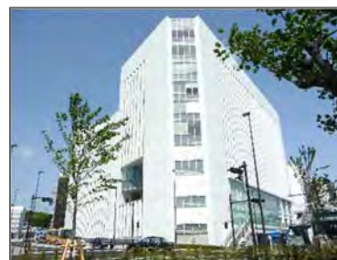
公益施設 （区民文化センター、区役所、 自転車駐車場ほか）
