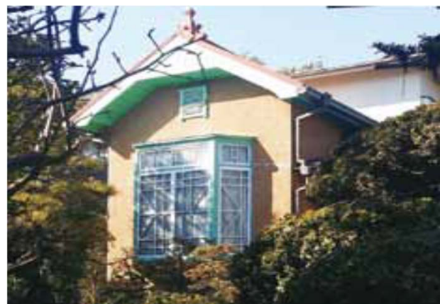
大正から昭和初期にかけて建てられた洋館付き住宅
