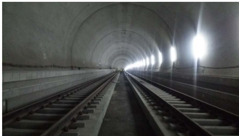
神奈川東部方面線の整備(現状)
