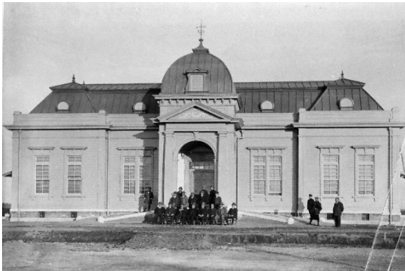
創設時の西谷浄水場の建築 （国登録有形文化財）
