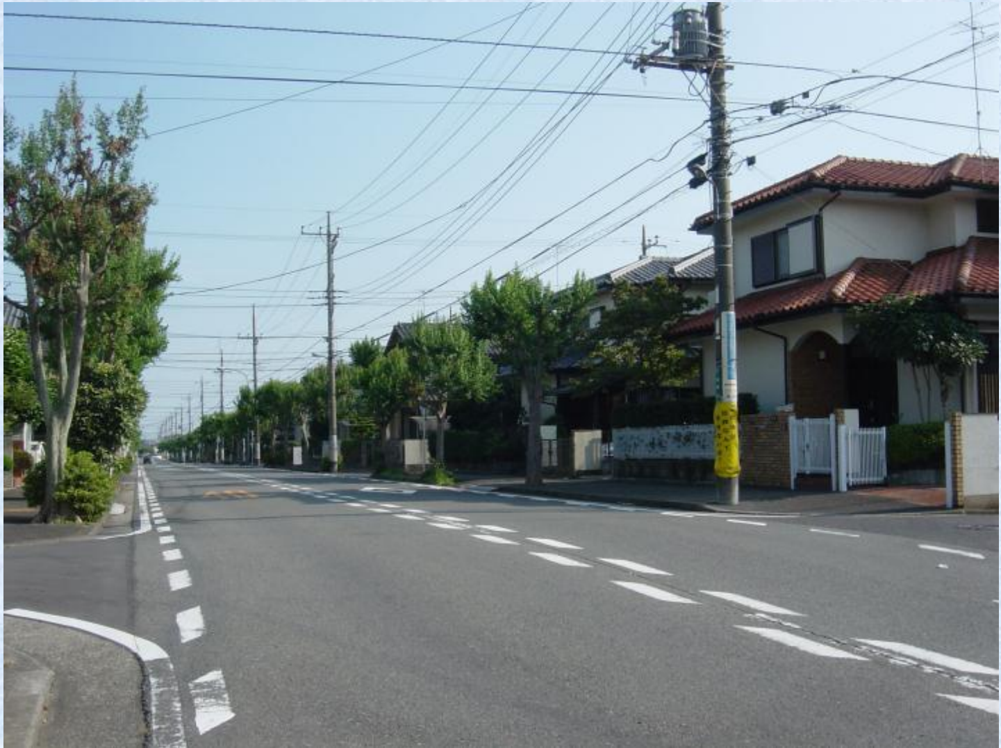
瀬谷地内線 完成区間(瀬谷区東野)
