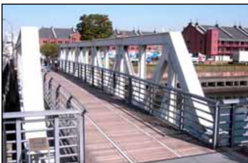
地区の玄関口としての橋（新港橋）
