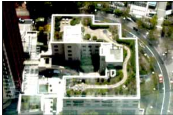
屋上庭園を設けた事例(東京都港区)
