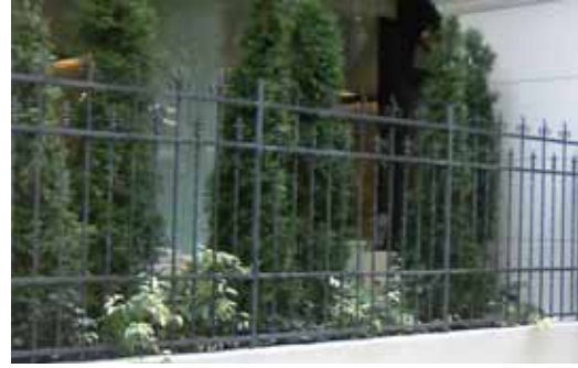
透過性が高く落ち着いた色彩のフェンス（関内地区）
