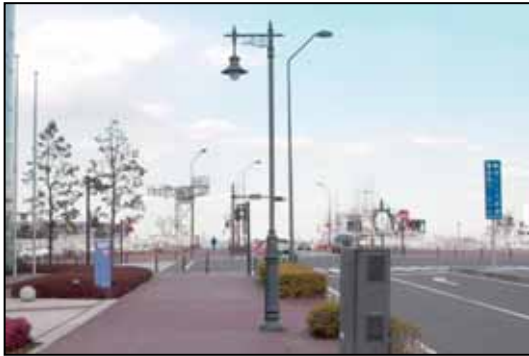
新港3号線（万国橋通り）
