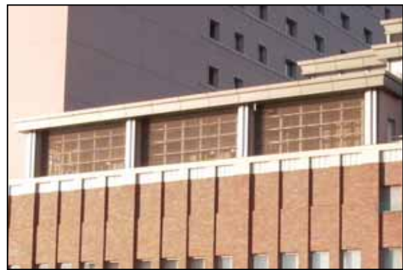
設備類を覆い隠すことによる修景
