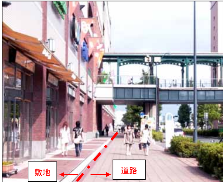
敷地と道路との一体的な舗装
