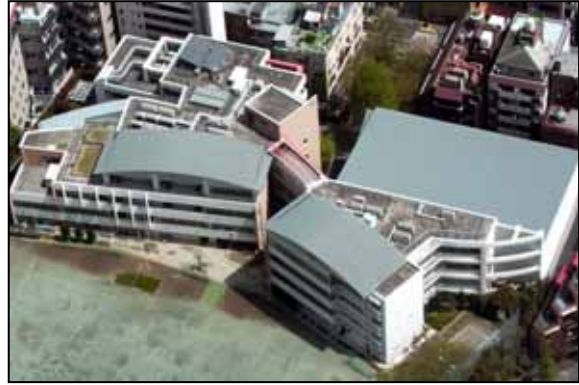
見下ろし景観に配慮した屋根の事例(東京都港区)
