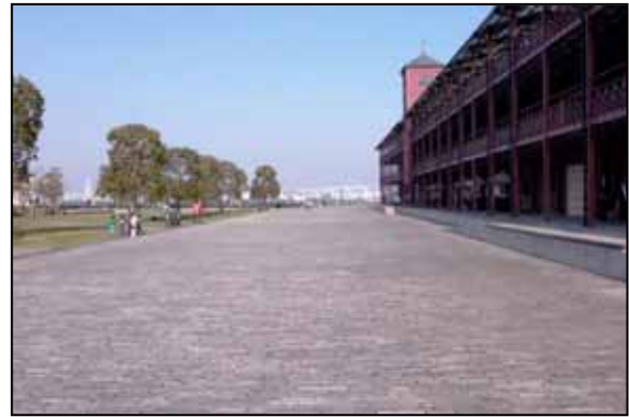
新港埠頭花崗石舗石道
