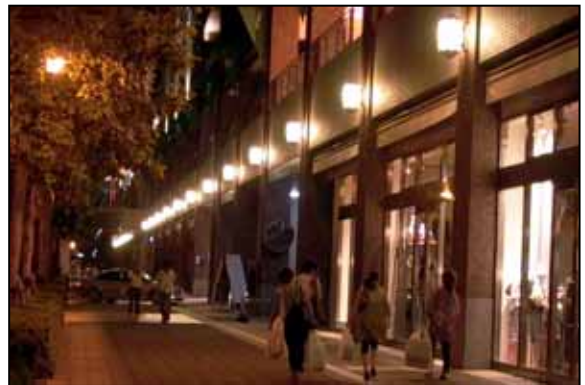
歩行空間に沿って壁面に設置された照明
