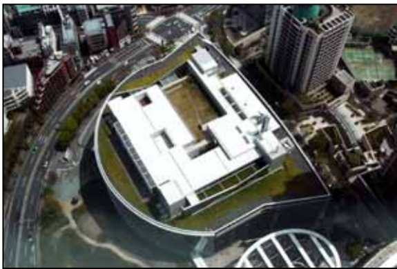
見下ろし景観に配慮した設備類を修景した事例（東京都港区）
