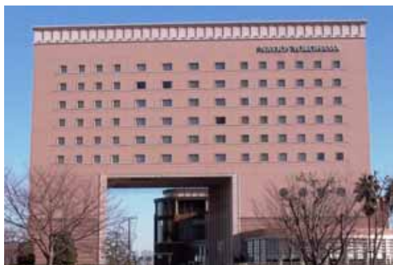
落ち着いた高層部の壁面看板
