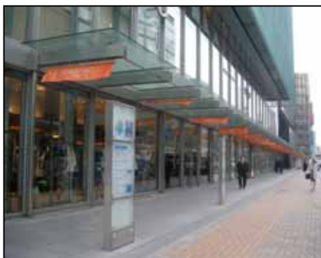
低層部の賑わい空間とセミパブリック空間の確保による活気の演出をした事例 (東京都中央区)
