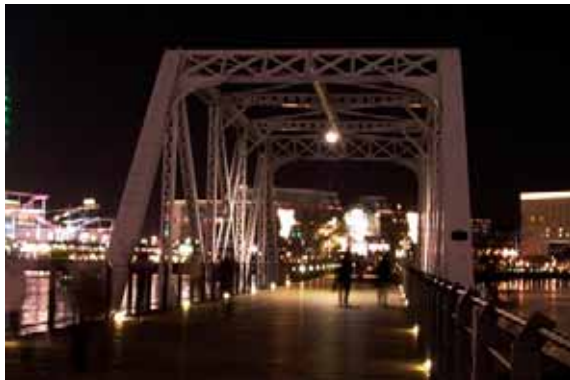
“島”への入口を演出する照明（汽船道）
