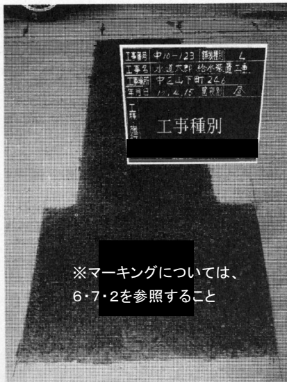
道路内仮復旧完了状況写真
