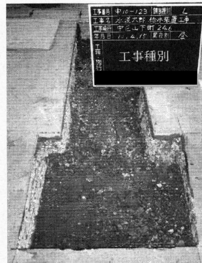
埋め戻し完了状況写真
