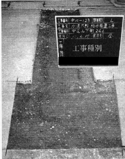
道路内路盤工完了状況写真
