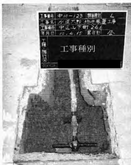
道路内配管施工状況写真
