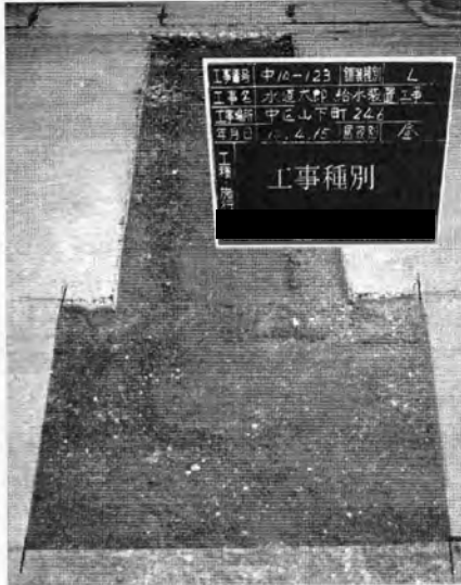
道路内路盤工完了状況写真
