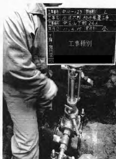
密着形コア挿入機設置状況
