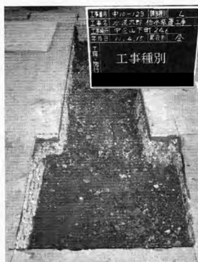
埋め戻し完了状況写真
