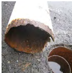
ポール看板の倒壊
