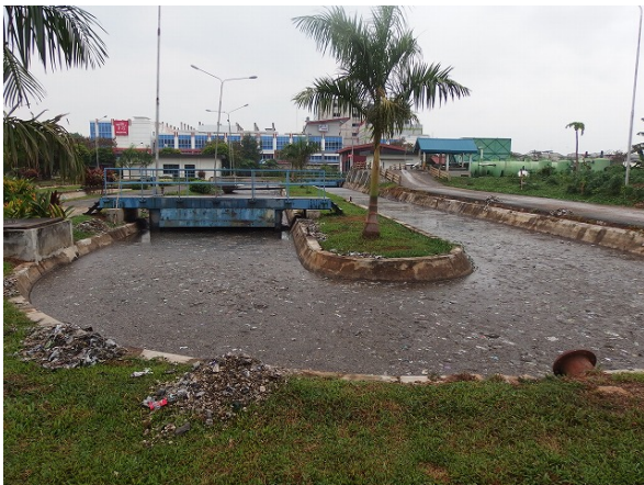
バタム市の下水処理場（オキシレーションディッチ）
