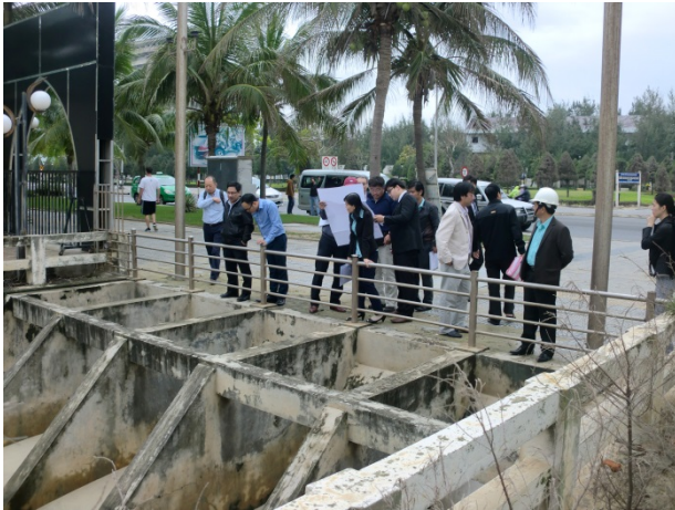
東海岸地域の下水施設（雨水吐き）の調査
