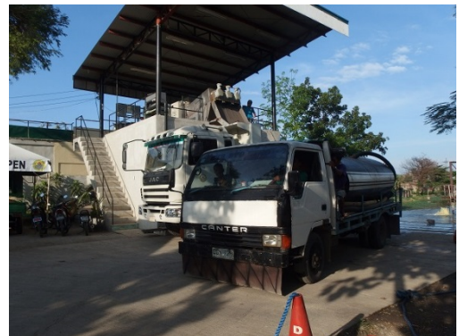
写真2 セブ市に建設したし尿処理施設(施設上部にアムコン社の汚泥脱水機を設置)
