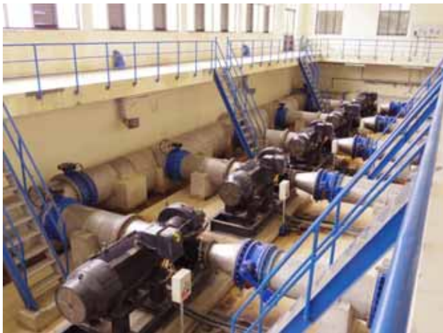
写真2 カウドウ浄水場
