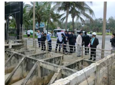
両市職員による合同現地調査 (ダナン市内の下水施設：雨水吐)
