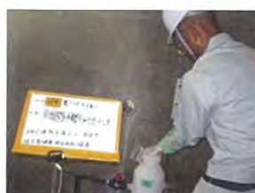
固形塩素投入
