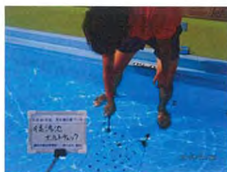
排水溝ボルトチェック
