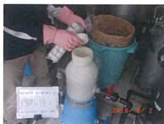
固形塩素投入
