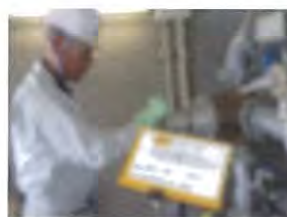
25mプール逆洗作業
