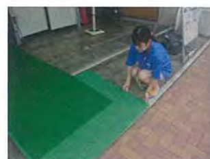
スロープ設置
