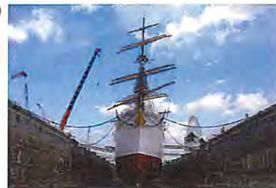
帆船日本丸大規模修繕工事
