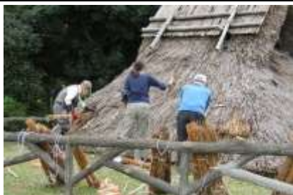
茅葺き屋根補修（差し茅）
