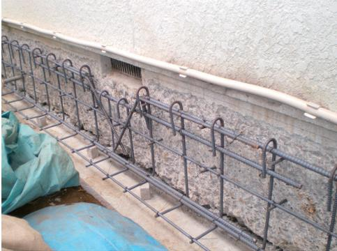
昭和 56 年以前の建物の多くは、基礎に鉄筋が入っていません。地震による力で基礎が壊れないように既存の基礎に沿って鉄筋コンクリートの基礎を補強します。
