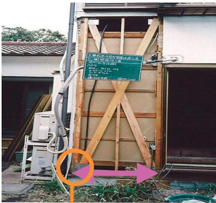
地震の力に抵抗できるように、斜めの木材＝筋かいを壁の中に設置して補強します。
