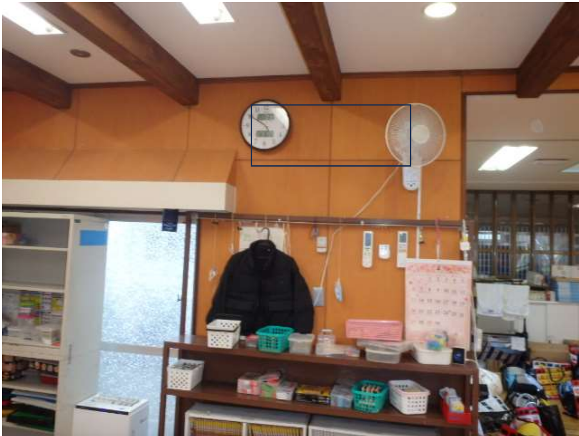
室内機（壁掛扇風機・時計移設）
