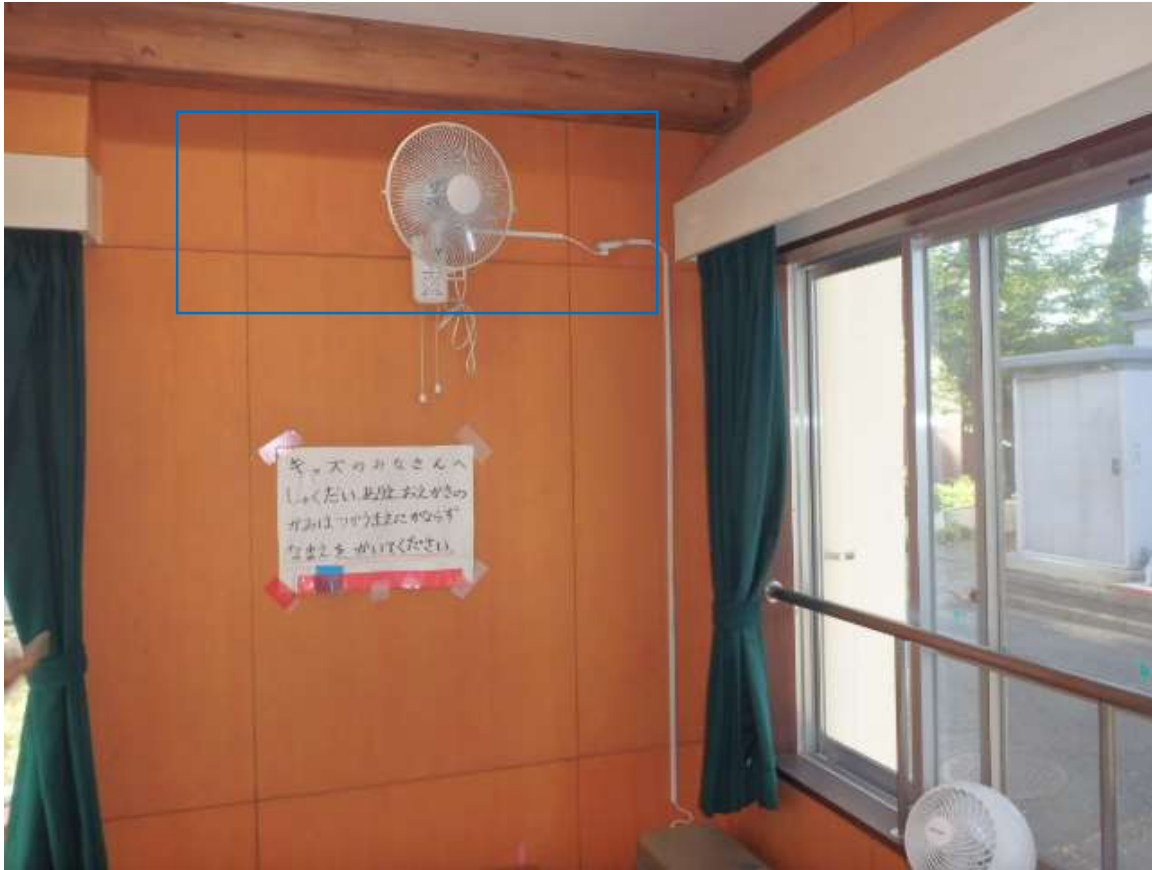
室内機（壁掛扇風機移設）
