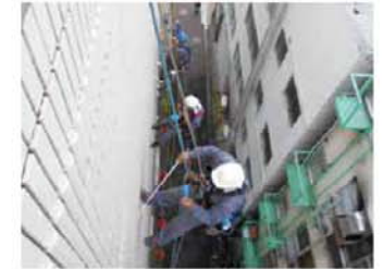
外壁点検（法定点検）
