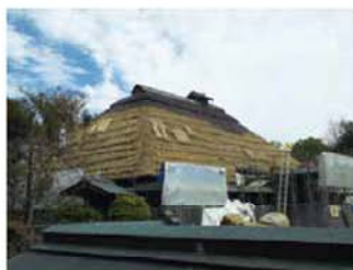
茅葺屋根 葺き替え（公園 古民家）
