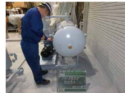
循環器設備更新（工場検査）
