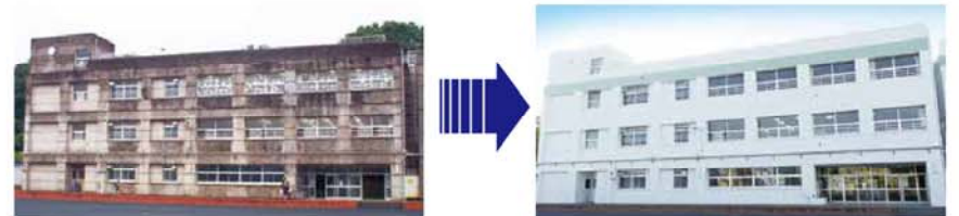
学校施設 外壁改修工事
