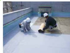
屋上防水（建物漏水対応）
