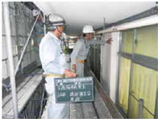
外壁改修（工事監理）
