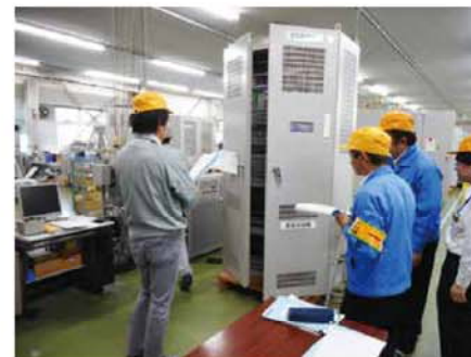
直流電源装置更新（工場検査）
