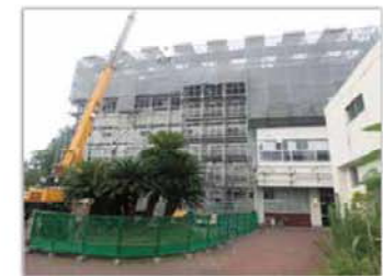
足場組立中（学校施設運営中）
