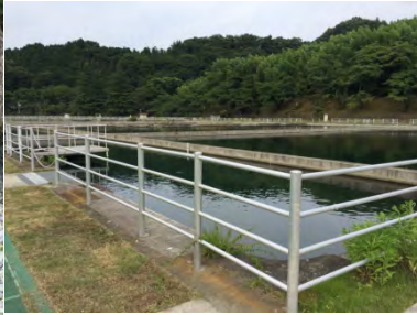
(写真4) 青山沈でん池
