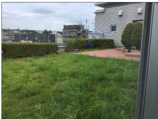
(写真9) 屋上緑化
