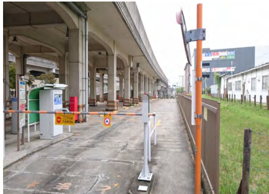
隣接する有料駐車場
