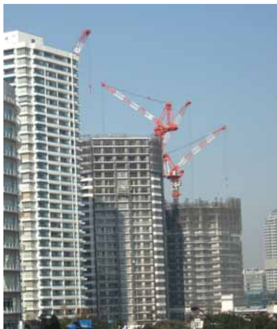
(39・50街区付近の建設中のマンション群)
