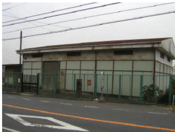
写真 7 大柵ポンプ場
