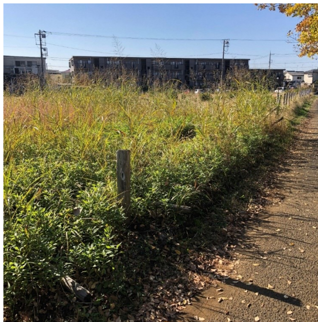
(公園予定地の倒壊した防護柵：監査人撮影)
