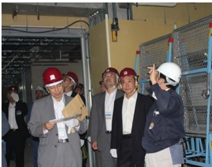
瀬谷区総合庁舎整備工事の現場を確認する監査委員
