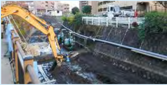
▲土砂堆積を除去している様子
