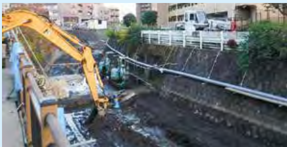
▲土砂堆積を除去している様子
