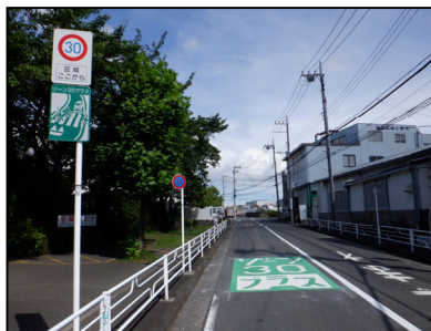
⑤、⑦ゾーン30プラス標識・標示
