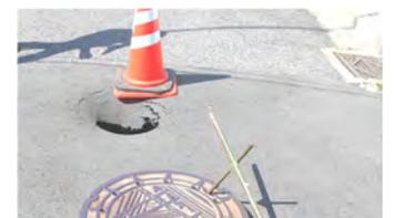
取付管破損による道路陥没
