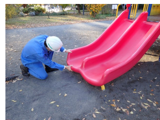
遊具点検の例
