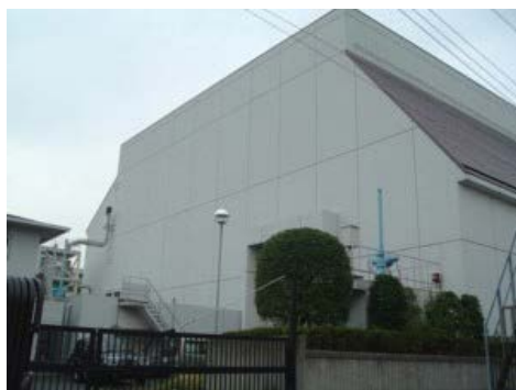
高田ポンプ場外観
