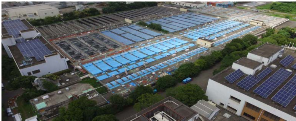
（図）北部第二水再生センターの外観
