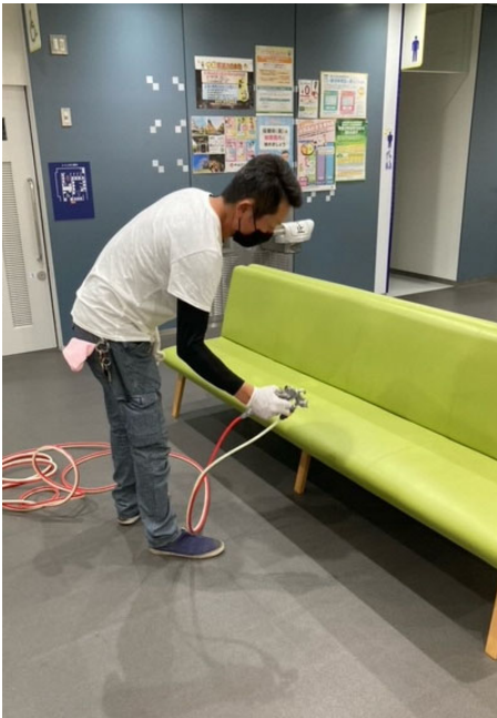
施工時の様子 (区庁舎)
