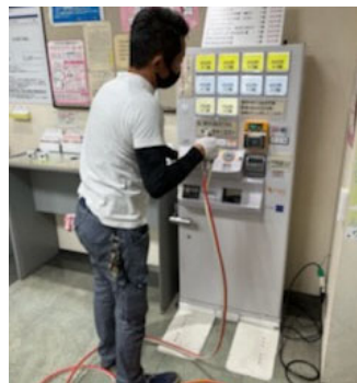
施工時の様子 (港南台行政サービスコーナー)
