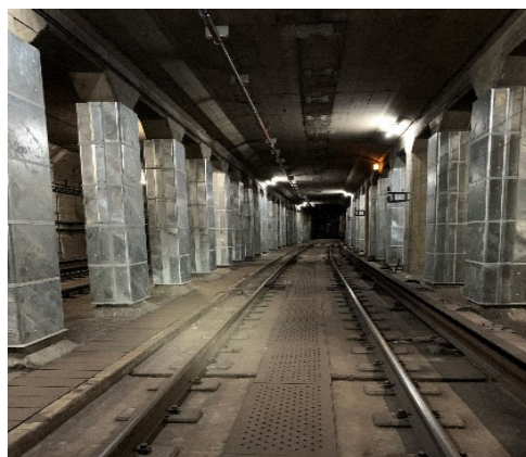
<開削トンネル部>
