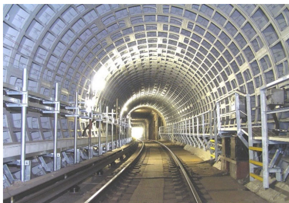
<シールドトンネルの補修>
