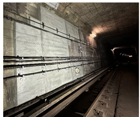
<開削トンネルの補修>
