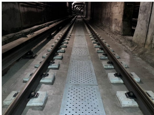
<軌道改良工事施工後>
