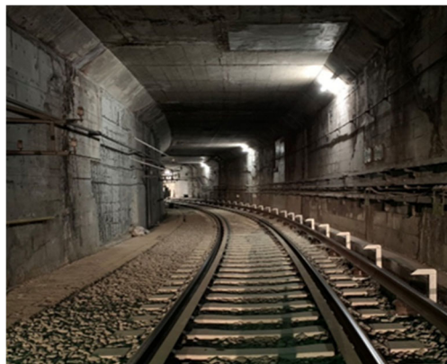
<急曲線軌道改良工事施工後>
