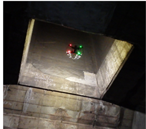
<ドローン試験施工>
