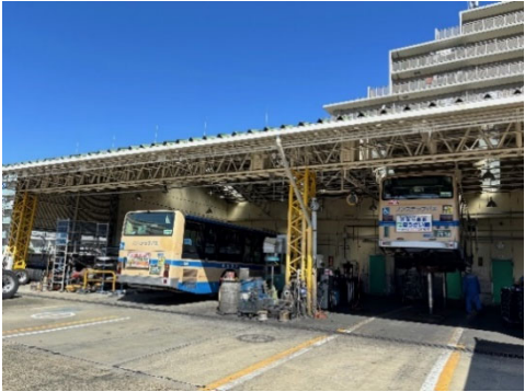
<緑営業所車両整備工場>
