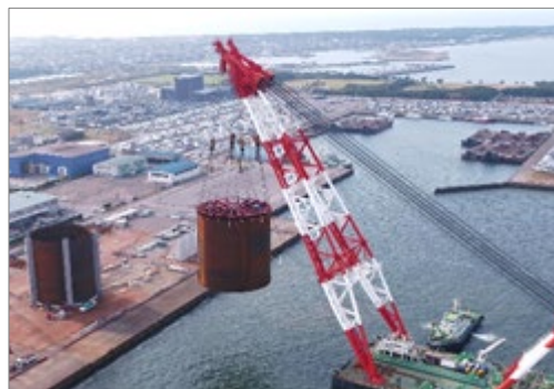
【新本牧ふ頭に設置する製作中の鋼板セル（富津）】
