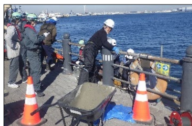
【赤レンガパーク護岸改修】
