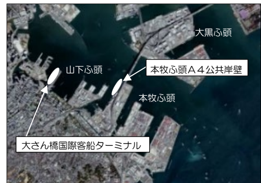
【陸上電力供給設備の整備箇所】
