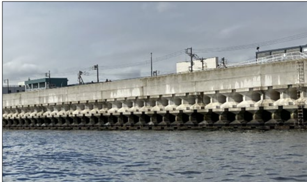
【金沢区福浦地区護岸復旧状況】
