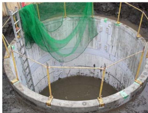
<防火水槽新設工事>
