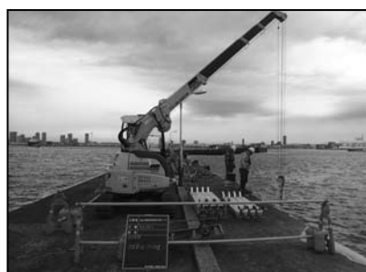
大黒ふ頭電気防食工事
