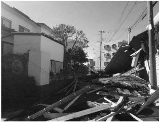
住宅の損壊（磯子区）
