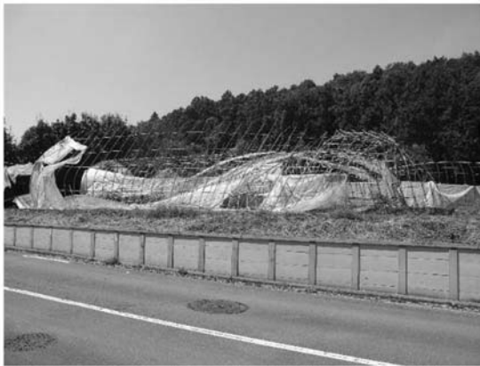
ビニールハウス全壊（戸塚区）
