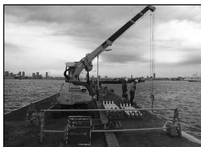
大黒ふ頭電気防食工事
