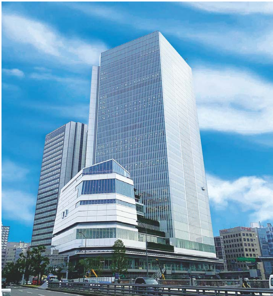
横浜市新市庁舎（令和2年6月29日全面供用開始）
