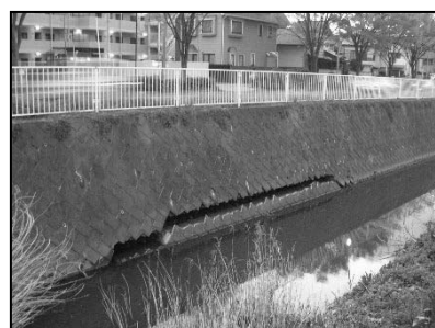
平戸永谷川の河川護岸崩落
