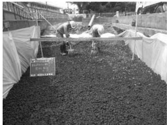
図4：貯留浸透材の設置状況（横浜市中区柏葉公園）
