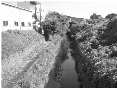
河川の 護岸改修
