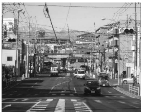
無電柱化の 状況
