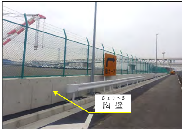
大黒ふ頭に整備した胸壁
