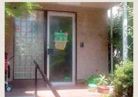
保育室入り口。病院隣接の空き家を改修
